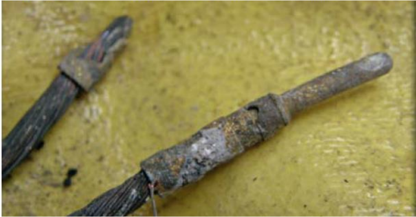
Figure 3-21: The remains of two connectors from the debris of a house [9] (photo: Institut für Schadenverhütung und Schadenforschung (IFS))
