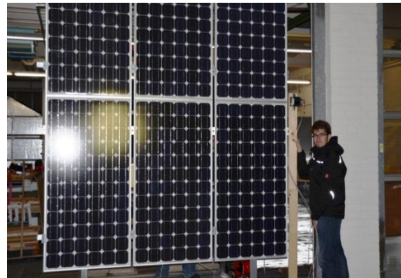
Bild 4-26: Messung der durch die Strahler erzeugten Einstrahlung in Modulebene (oben, unten, seitlich und mittig)
