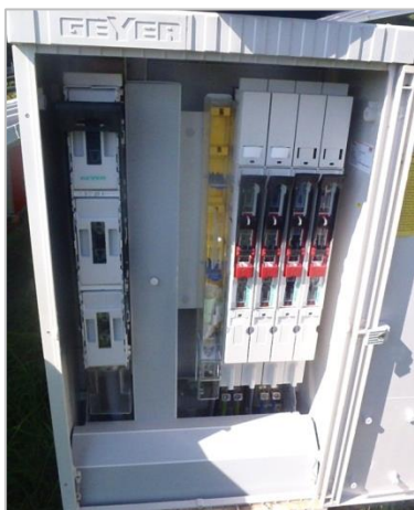
Bild 5-38: Sicherungshalter mit Trennfunktion
