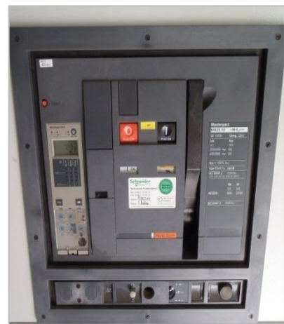
Bild 5-40: Lasttrennschalter
