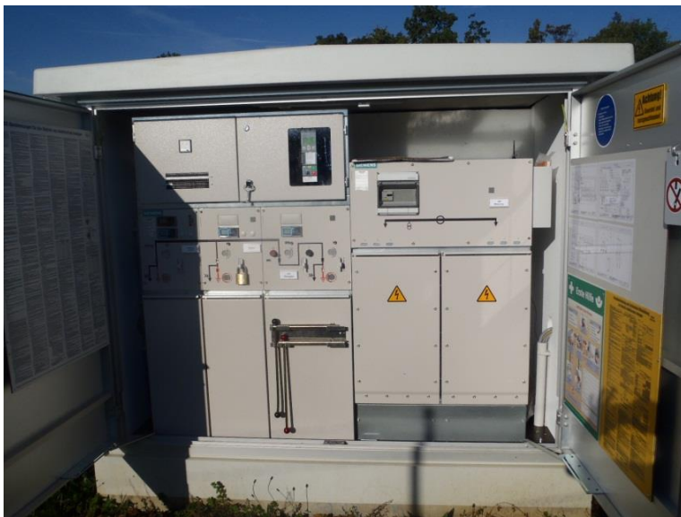
Bild 5-41: Mittelspannungsschaltstation
