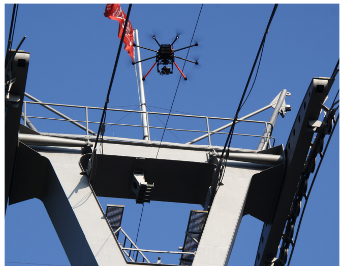
Inspektion eines Seilbahnpylons
