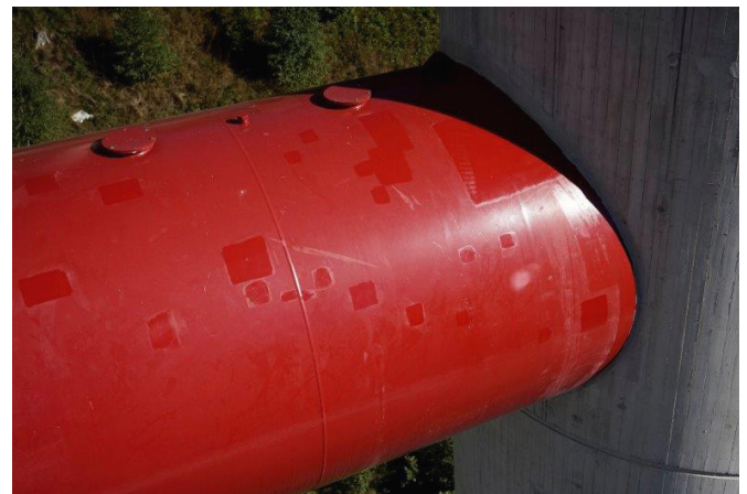
Inspektion einer Talbrücke (hier: Querriegel eines Brückenpfeilers)
